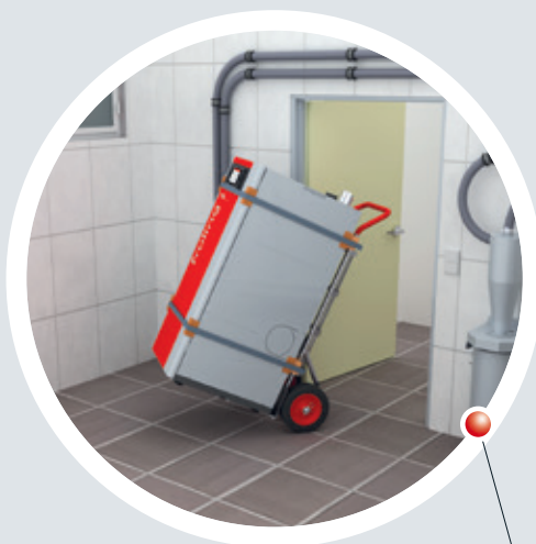
Mise en place à l'aide d'un diable
