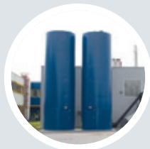
Silo en acier
