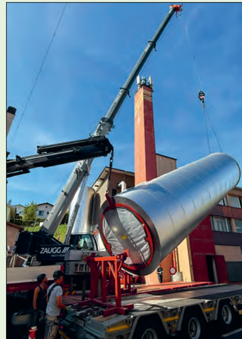
Manœuvre spectaculaire le lundi 6 juillet à Reconvilier avec la livraison de deux accumulateurs de chaleur d'une capacité de 50 mètres cubes chacun à la centrale de chauffage à distance RU-Calor SA. (photo ldd)
